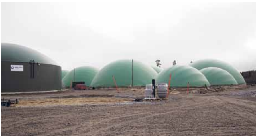
Investointi biokaasulaitokseen vähentää ympäristön kuormitusta. Snellmanin Lihanjalostuksen hiilidioksidipäästöt vähentyvät 3000 tonnia/vuosi ja öljy energian lähteenä pyritään korvaamaan kierrätyksestä saadulla kaasulla vuoden 2014 aikana.
